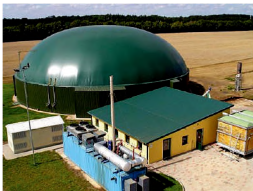
97. ábra. Biogáz-energiatermelő berendezés (Kijev megye)
