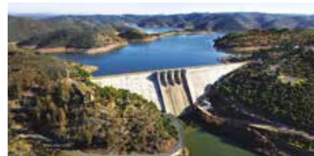
Rys. 242. Powstanie zbiornika wodnego na rzece
