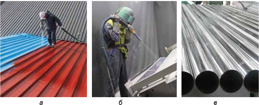
Мал. 10. Боротьба з корозією металів: а – неметалічне покриття металів; б – металічне покриття металів; в – виробництво нержавіючої сталі
