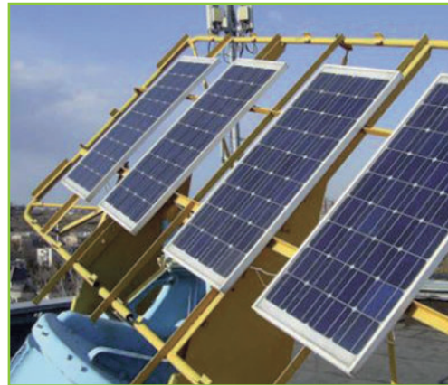
Мал. 13. Кут нахилу сонячних колекторів на геліотермальній електростанції
