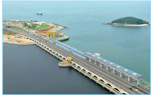
Мал. 271. Припливна електростанція в Південній Кореї
