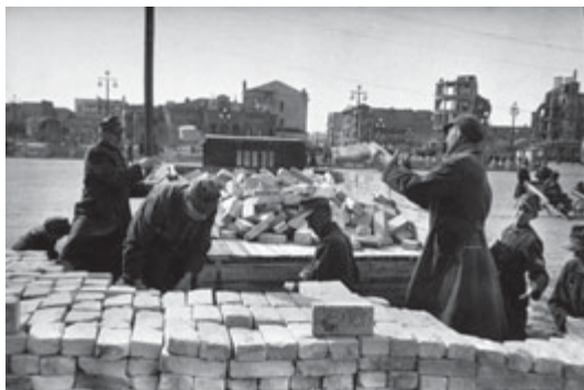
Німецькі військовополонені на відбудові зруйнованого міста
