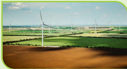
Мал. 122. Ботіївська вітрова електростанція
