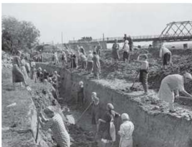
↑ Цивільне населення на будівництві протитанкових укріплень. 1941 р.
