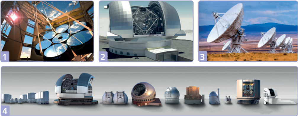
Мал. 140: 1 — Великий Магелановий телескоп (7 дзеркал діаметром 8,4* м); 2 — Дуже Великий Телескоп E-ELT (дзеркало діаметром 39* м); 3 — Дуже великий масив радіотелескопів ім. Карла Янського; 4 — порівняльні розміри телескопів
