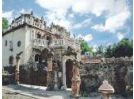
Будинок Голованя. Луцьк
