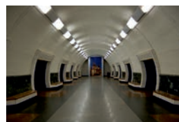
Станція метро «Дорогожичі»
