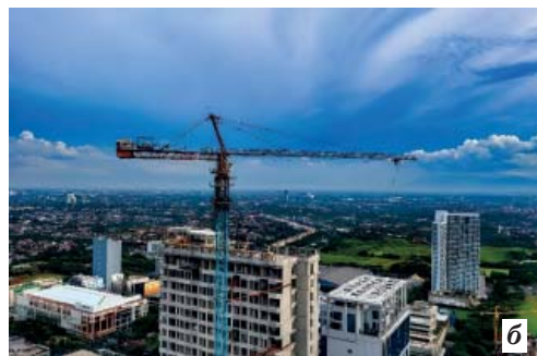
Мал. 33.2. Складні механізми: а — кар'єрний екскаватор; б — баштовий кран
