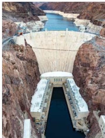
Мал. 38.6. Гребля гідроелектростанції
