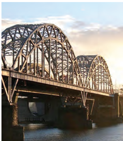
Дарницький міст через р. Дніпро
