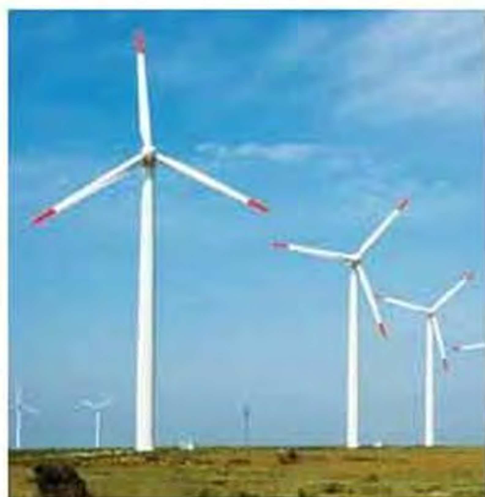
Мал. 145. Вітрова електростанція
