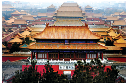
Orașul Interzis din Beijing (China) – cel mai grandios complex de palate din lume, construit din ordinul împăratului Zhu Di (fotografie modernă)
