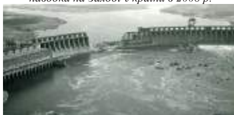
Іл. 33.7. Зруйнована вибухом гребля Дніпрогесу в 1941 р.
