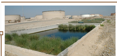
Рис. 28.4. Очищення води, забрудненої під час роботи сховища нафтопродуктів, здійснюється завдяки рослинам
