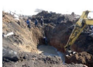
Іл. 75.9 Викопування водовідвідної каналу
