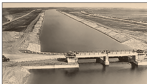
Шлюз на Північно-Кримському каналі (1960-ті). Гігантська іригаційна споруда, зведена у 1961–1971 рр., постачала дніпровську воду з «материка» в Крим
