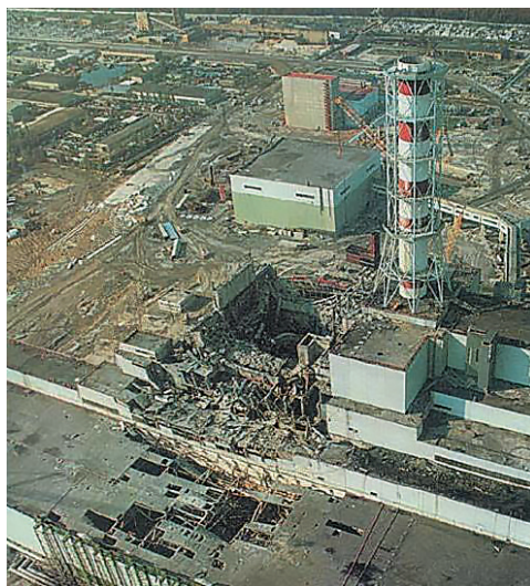
Зруйнований реактор на Чорнобильській АЕС
