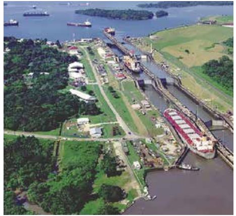
Мал. 144. Прохід судна через шлюз Панамського каналу
