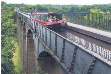
Мал. 54. Судноплавний акведук Понткісіплте занесено до списку Світової спадщини ЮНЕСКО як «досягнення цивільної інженерії»
