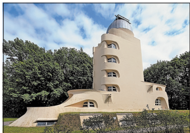
„Turnul lui Einstein” („Einsteinurm”) la Potsdam, construit în 1921. Imagine contemporană.
