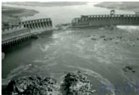
Іл. 40.8. Зруйнована вибухом гребля Дніпрогесу в 1941 р.
