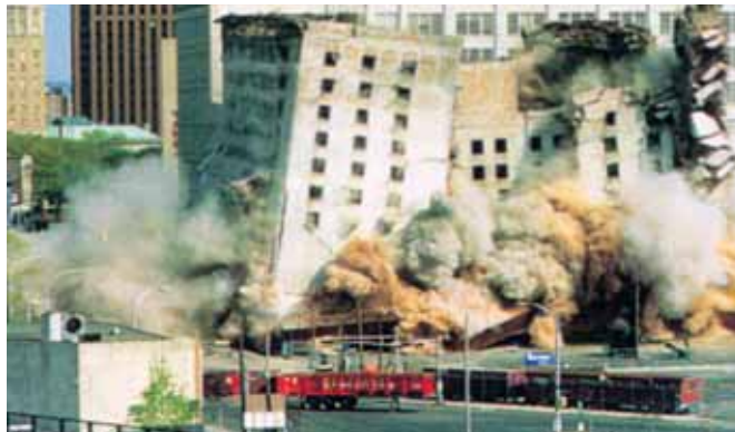
Мал. 94. Динаміт використовують для демонтажу будівель
