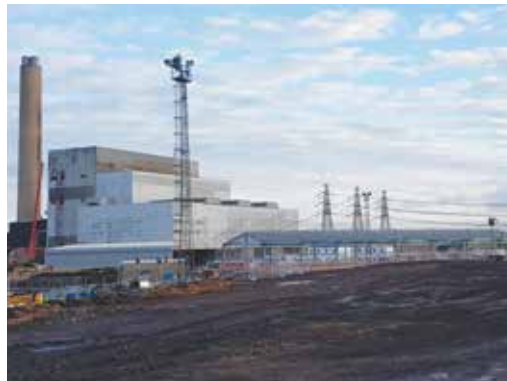
Мал. 105. Алюмінієвий завод розташовано на відстані лише 800 м від електростанції, що забезпечує його електроенергією (Велика Британія)
