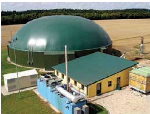
Мал. 97. Біогазова установка (Київська область)
