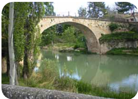
El puente sobre el Río Tajo, Castilla – La Mancha.
